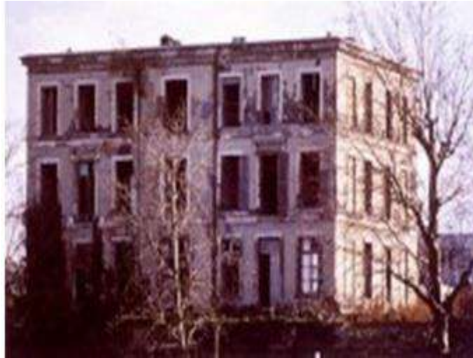
Figure I.1 : Maison de François Coignet à Saint-Denis réalisée en béton aggloméré renforcé de barres métalliques [SABLOCRETE, 1994].
